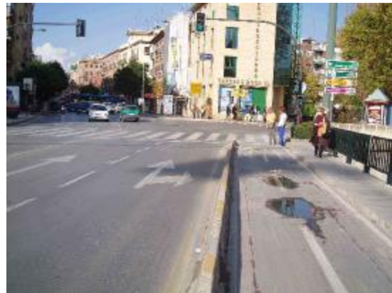
Carril bici con separación física en Puente Blanco (Granada)
